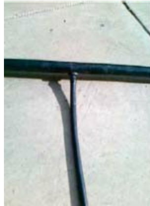
Fig. 5.1 Micro tubing
